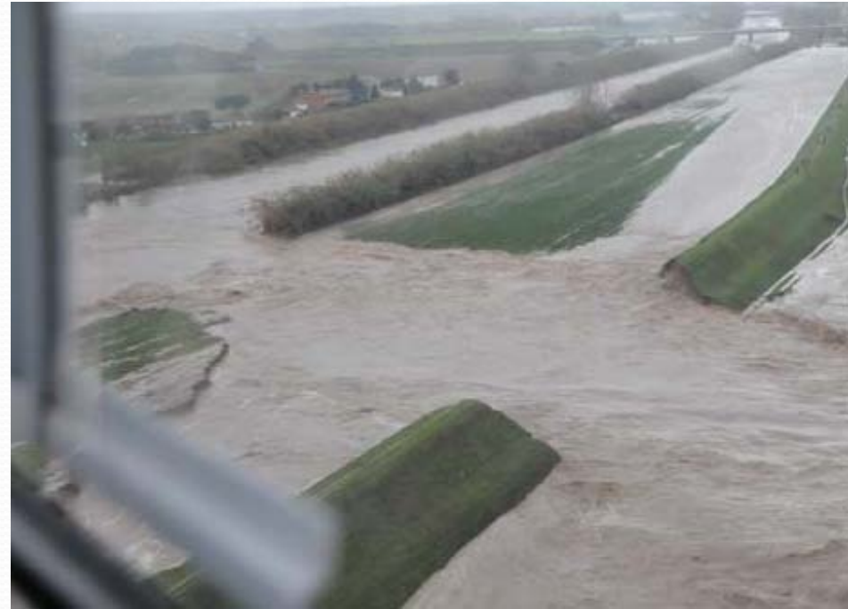
Rotta arginale in loc. Nodica durante la mattina del 25/12/2009 [Fonte: “La voce del Serchio”].
